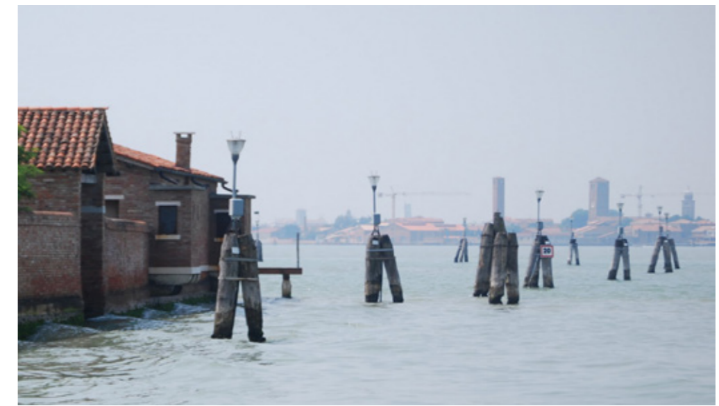
5. sponda Ovest, dalla Laguna - Canale Scomenzera San Giacomo
